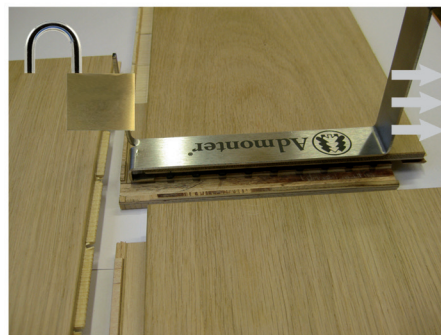
7. Rückwärts Verlegung Feder positionieren
